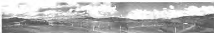
Fig. 10 – Alphaville – Lagoa dos Ingleses – Vista geral.
