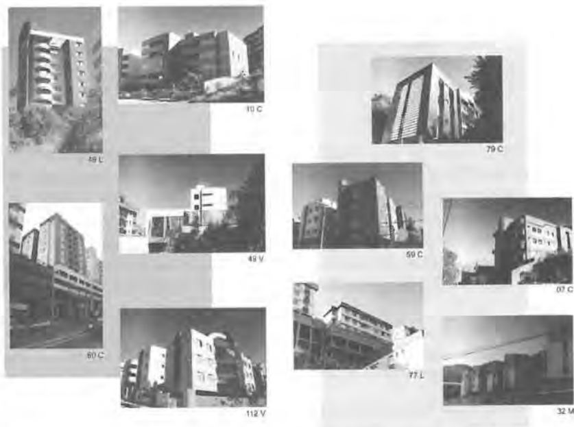
Fig. 3 e 4 – Edifícios apresentados nas entrevistas. A letra ao lado de cada um deles se refere às subáreas em que se localizam
