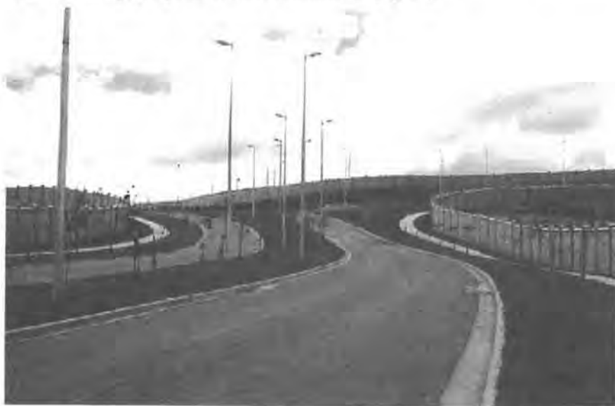
Fig. 11 – Alphaville – Lagoa dos Ingleses – Avenida Princesa Diana, acesso ao condomínio (muros).
