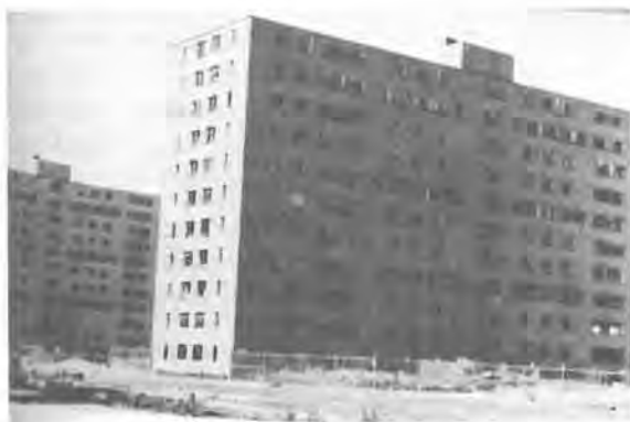
Fig. 1 – Conjunto habitacional Pruitt-Igoe, em Saint Louis. O espaço defensável muito pobre foi um dos principais problemas que acabaram por levar à opção de dinamitar o conjunto.
